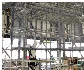
写真5 手揚げ下段揚重状況
