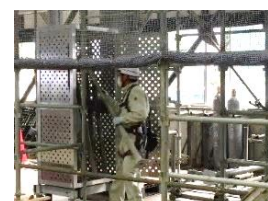
写真4 機械揚げ下段積み込み状況
