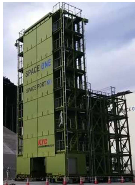
ロケット移動式射点組立足場
