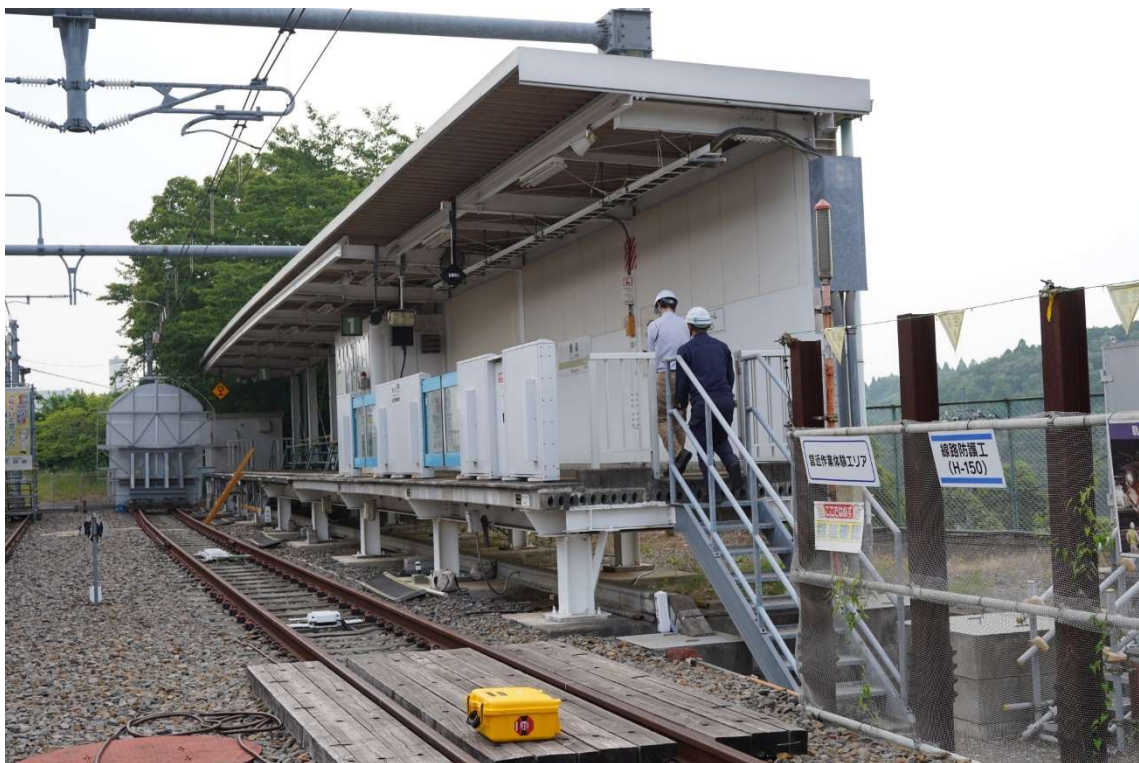
画像1）ホーム再現エリアにおけるスキャニング状況。ケースはスキャニングの始点、終点の目印になる。
