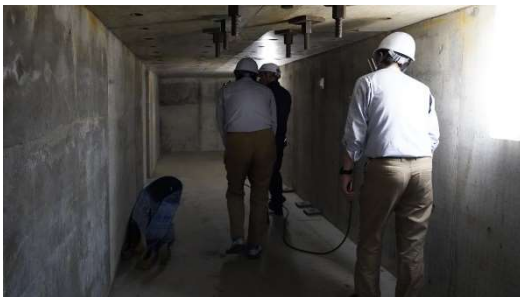
画像5) 地下空間施設のスキャニング状況
