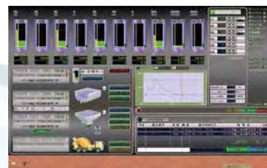
計量制御システム
