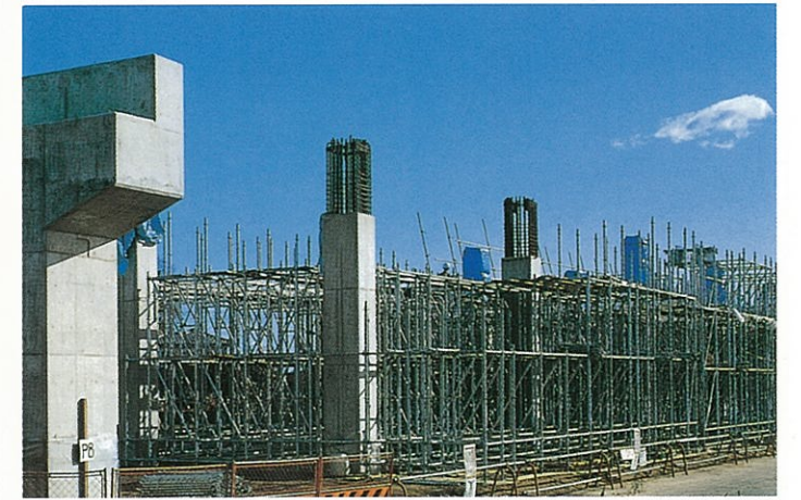
■北陸新幹線現場
