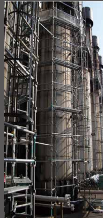
タンク改修工事
