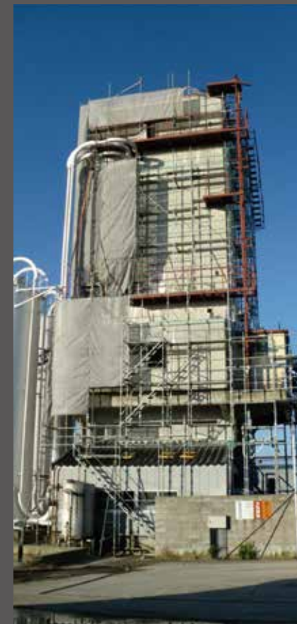
プラント改修工事
