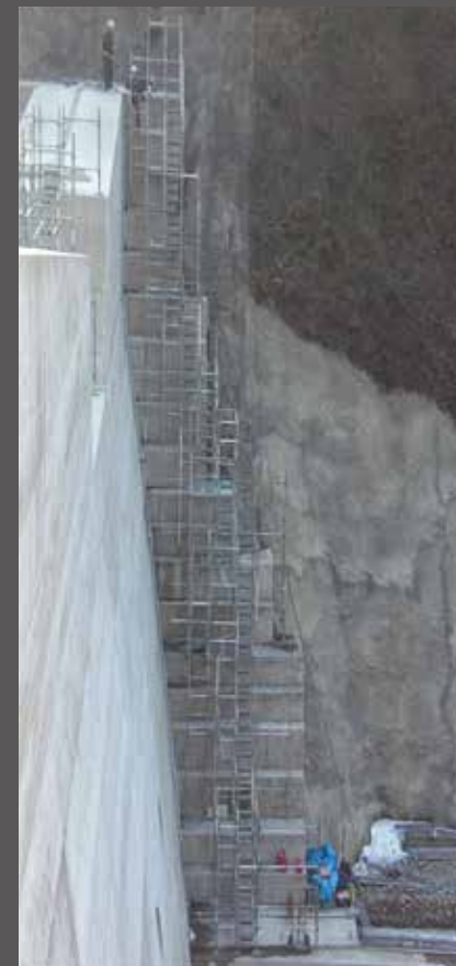
ダム改修工事
