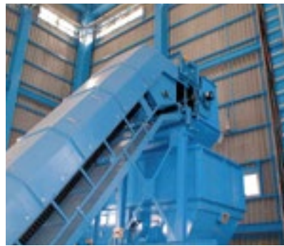
① 建設廃材設備
