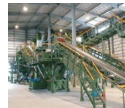
③ 土壌改良設備
