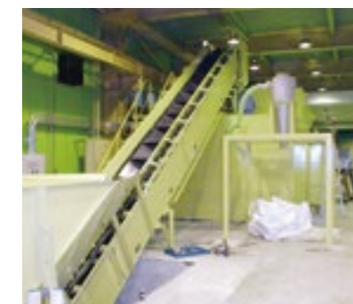
⑨ ペットボトル搬送コンベヤ
