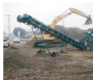
⑫ 土砂搬送コンベヤ (油圧モータ)
