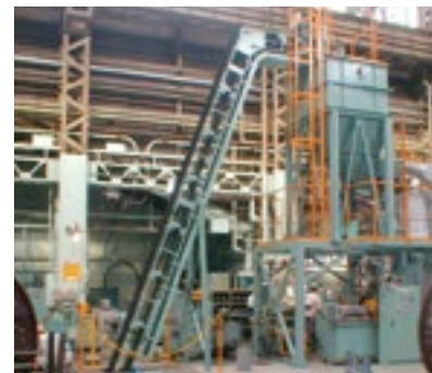
⑤ 鉛片搬送コンベヤ（急傾斜コンベヤ）
