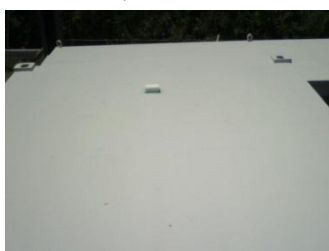
タフコートを塗布した鋼板製の屋根
