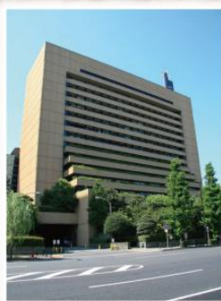
新聞社屋上タンク
