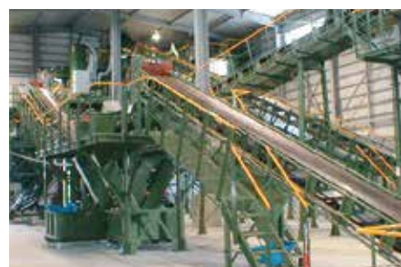
土壌改良設備
